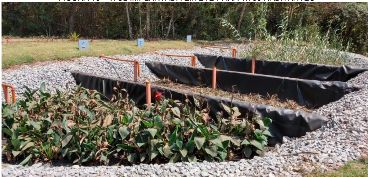
FIGURA 13 – WCL IMPLANTADA EM ETE PARA 1.750 HABITANTES
