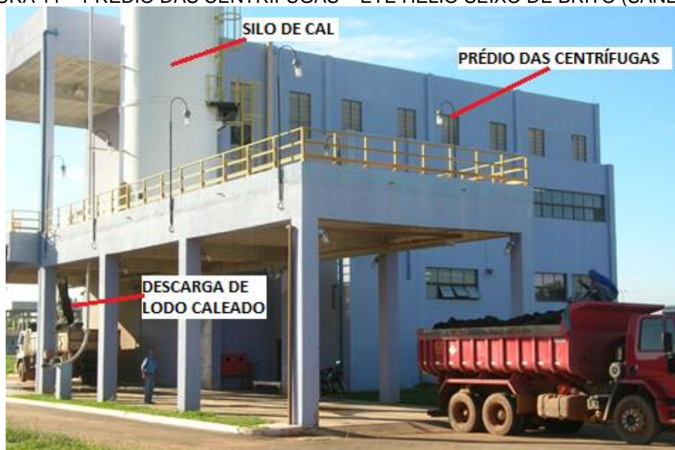
FIGURA 11 – PRÉDIO DAS CENTRÍFUGAS – ETE HÉLIO SEIXO DE BRITO (SANEAGO)
