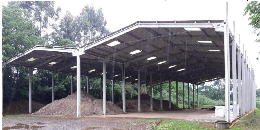
FIGURA 14 – PÁTIO DE CURA DA UGL ETE RONDA, PONTA GROSSA-PR (SANEPAR)
