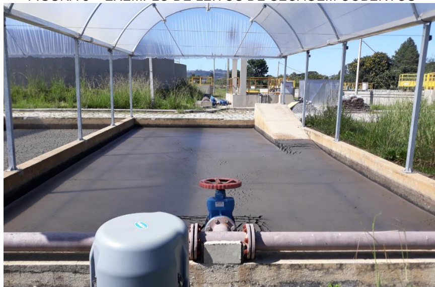
FIGURA 8 – EXEMPLO DE LEITOS DE SECAGEM COBERTOS
