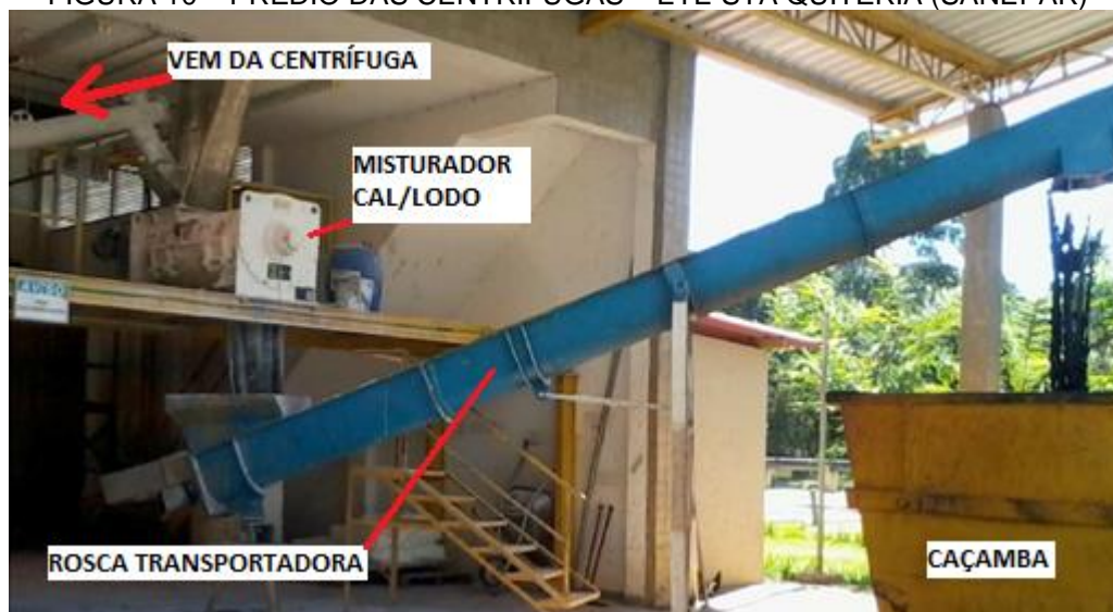
FIGURA 10 – PRÉDIO DAS CENTRÍFUGAS – ETE STA QUITÉRIA (SANEPAR)
