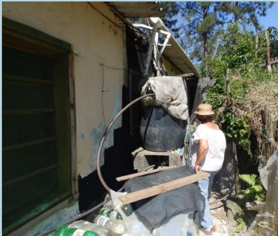
Residência que faz a captação de água da chuva – Jardim Canaã/ Itaquaquecetuba/SP.
